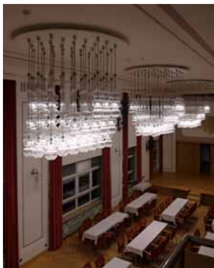
Obr. 3 Tři masivní rekonstruované lustry v Hudebním sále; kontakty, které by snesly záběrový proud (inrush current) přes tisíc ampérů všech 37 LED žárovek v každém lustru nejsou běžné; ovládání tedy bylo rozděleno do 5 sekcí
