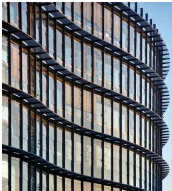
Kompletní řízení strojoven, klimatu v každé místnosti Moravské zemské knihovny v Brně včetně natáčecí skleněné fasády řídí předchůdce Foxtrotu ve dne i v noci již třináctým rokem.
